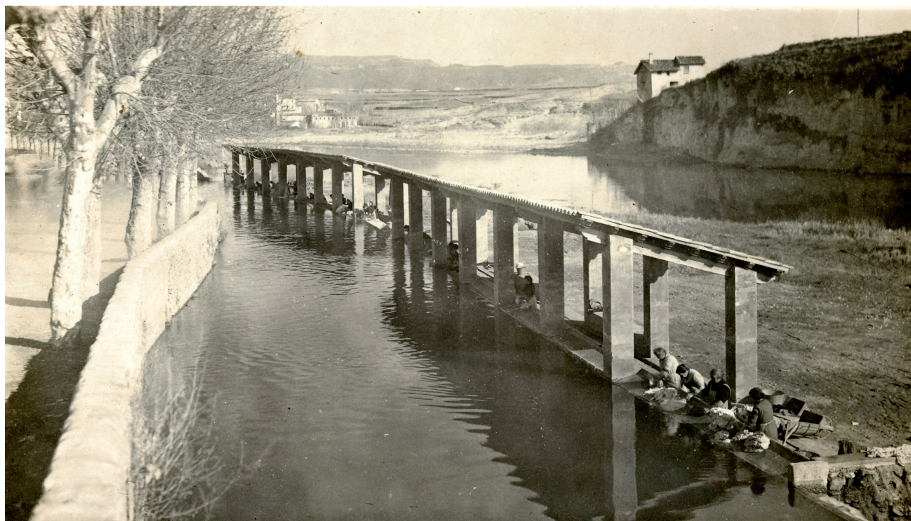
Rentants del final del passeig Sant Joan amb les dues construccions porxades. Any 1945. Foto: Jaume Gaja.
